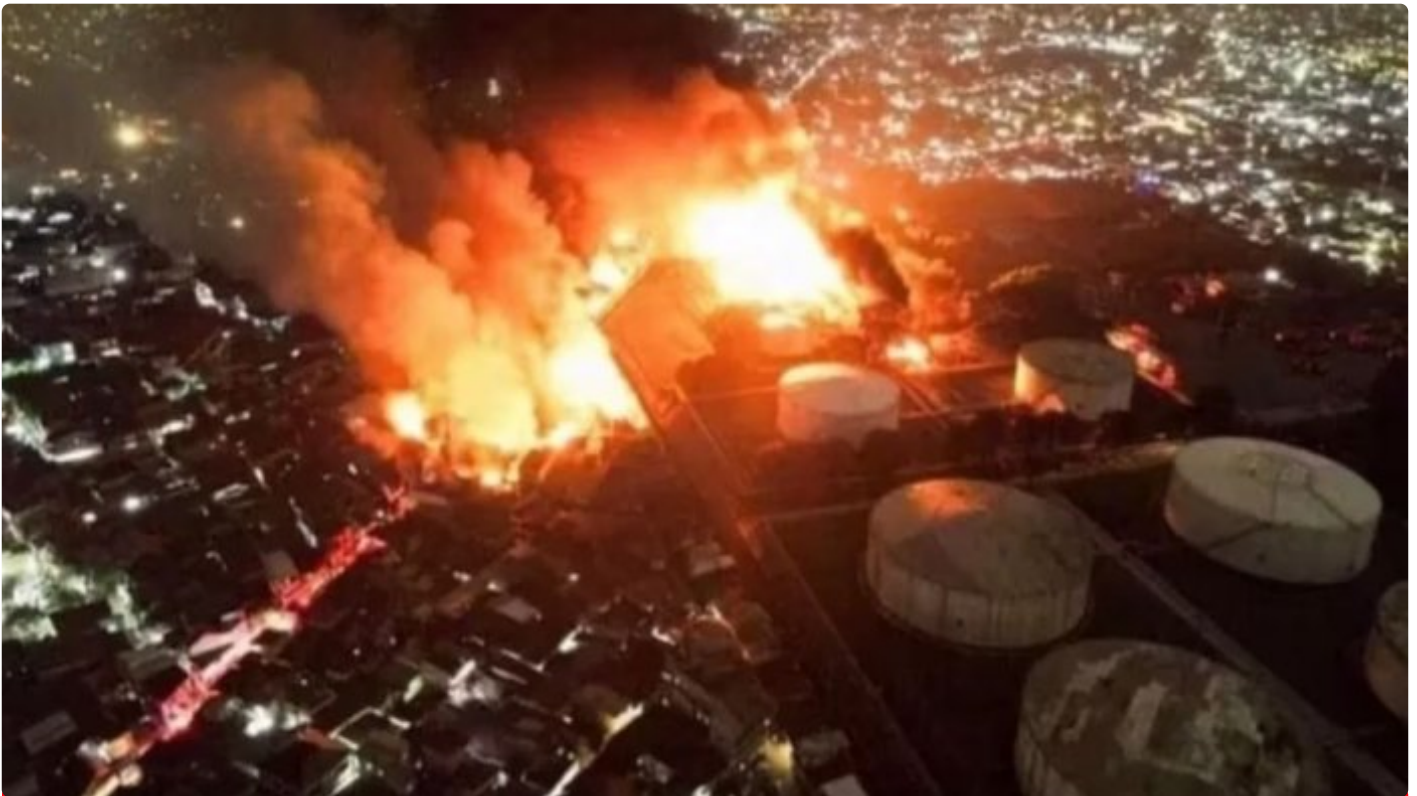
Depo Pertamina Plumpang Meledak
